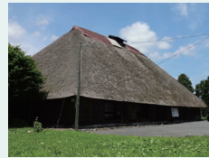
旧朴館家住宅 岩手県最大級の茅葺き民家。間口約30m、棟高16mと、圧巻の大きさ。(県指定有形文化財)
