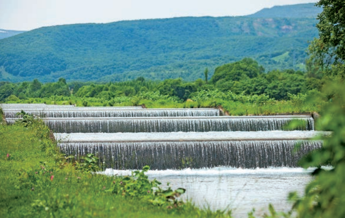
先人達の農業への想いが込められている「松川温水路」。緩やかな傾斜と落差を利用し、太陽熱で水を温める。
