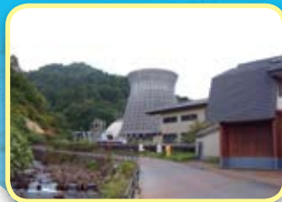
今年7月、日本機械学会により機械遺産に認定された松川地熱発電所。近くに松川温泉がある。
