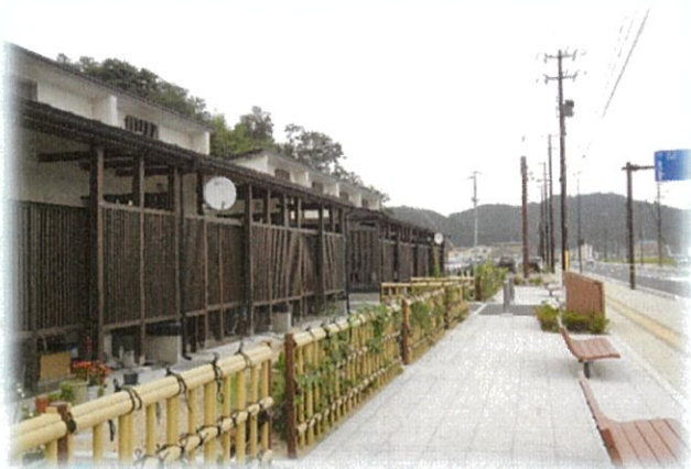
町家風情の災害公営住宅
